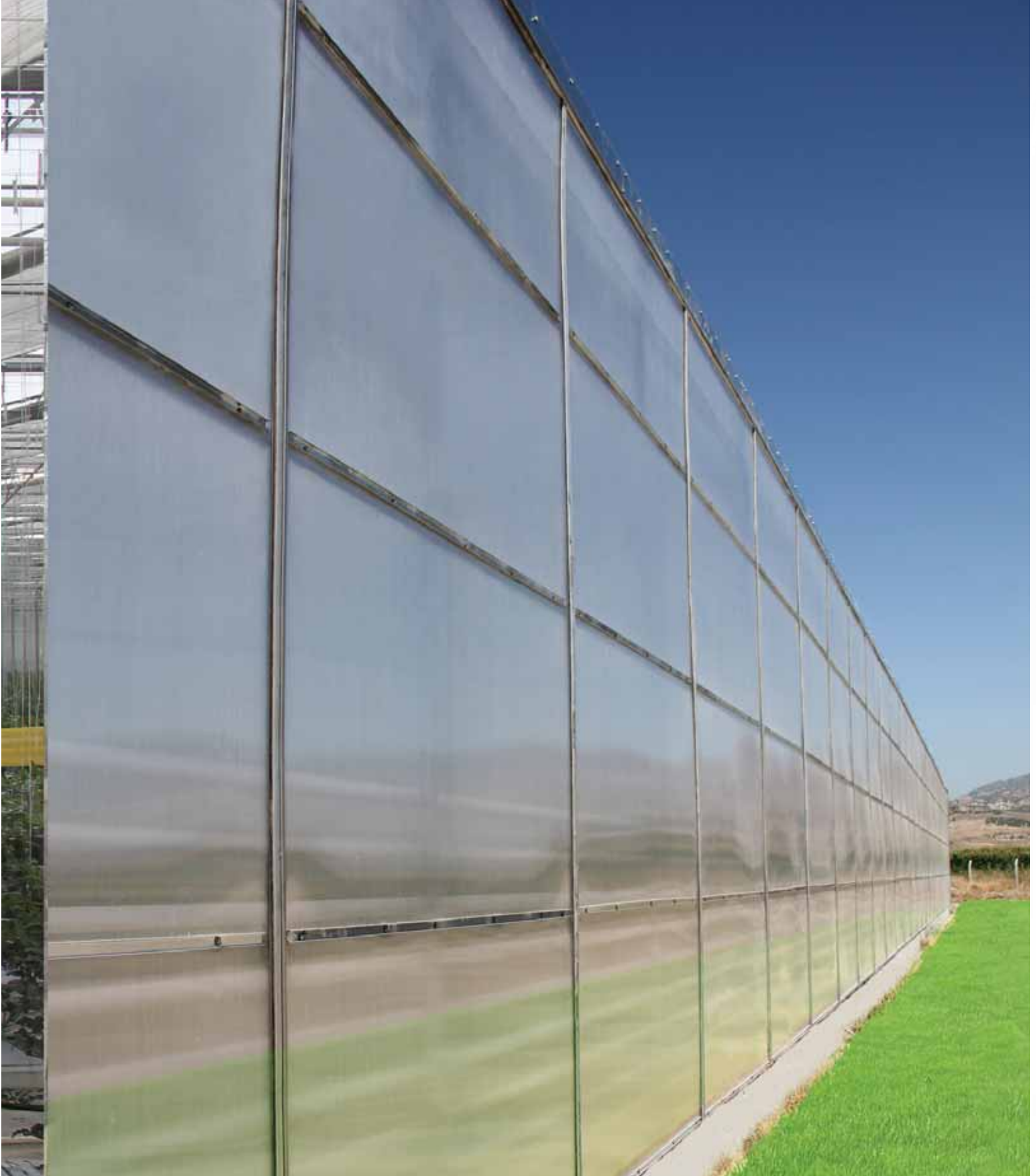
Türkiye'nin en büyük modern seraları Oluklu Polikarbonat: 7 duvarlı 16 mm 7W16, 4 duvarlı 8 mm 4W8, 2 duvarlı 6 mm ve 8 mm
